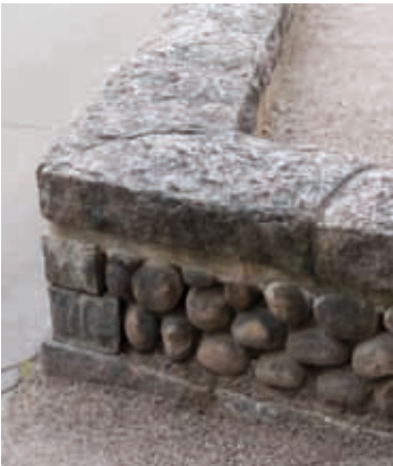
Karhupuiston tukimuuri 1910-luvun puolivälistä
