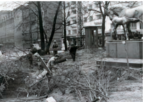
Kaisaniemenkadun leventämiseen liittyvää puiden kaatamista ja rakennustöitä Varsapuistikossa. Nya Pressen, 1951. MVA.
