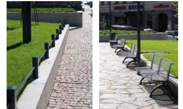
Kolmikulman uusia rakenteita vuonna 2008. Tukimuuri-kaideyhdistelmä ja uusi istuskelualue.
