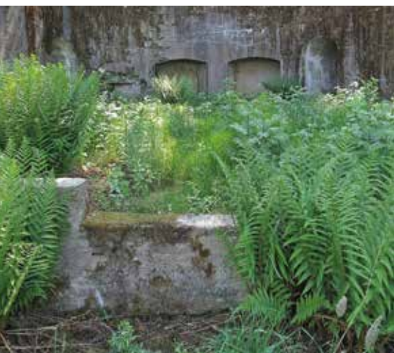
Batteriet på Kungsholmen
